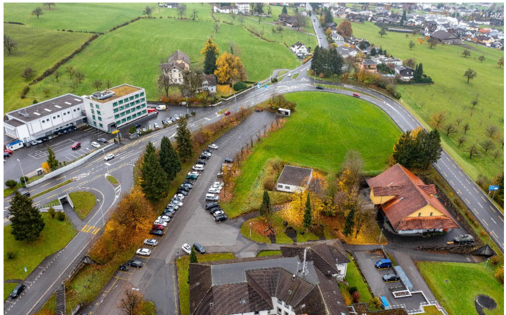
Abb. 8 Bestandsbauten [3], Blick von der Strasse H8
