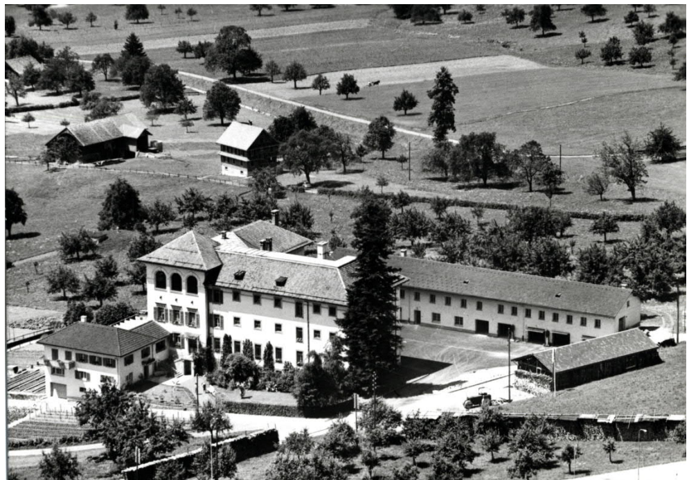
Abb. 4 Luftbild Schlagstrasse 87, Schwyz
