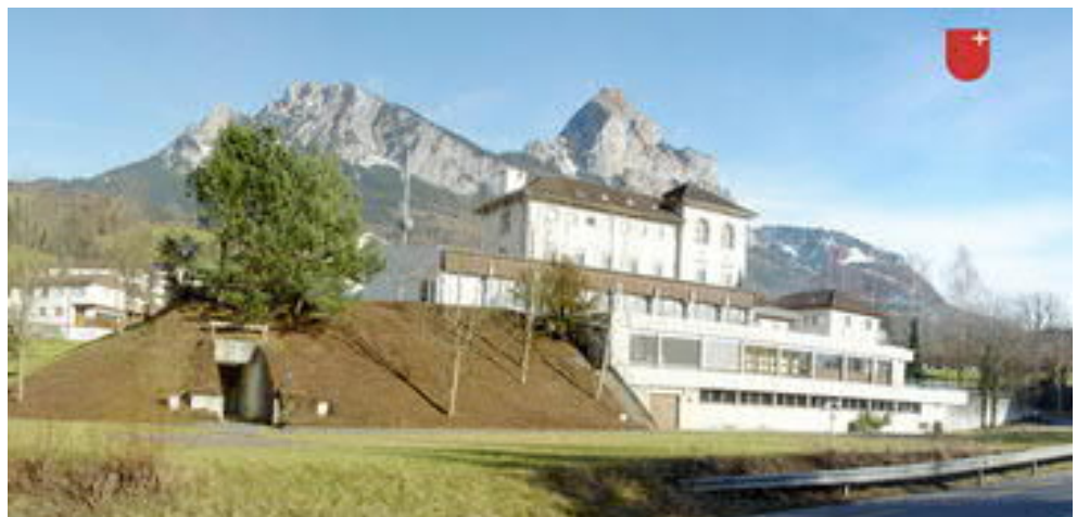
Abb. 7 Bestandsbauten [3], Blick von der Strasse H8
